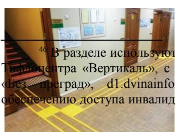
позволяющий незрячим людям получать информацию о безопасном пути движения (направления движения, повороты) и о наличии препятствий на пути движения (пороги, перекрестки, ступени, лестницы, столбы или колонны, двери, пешеходные или подземные переходы).
