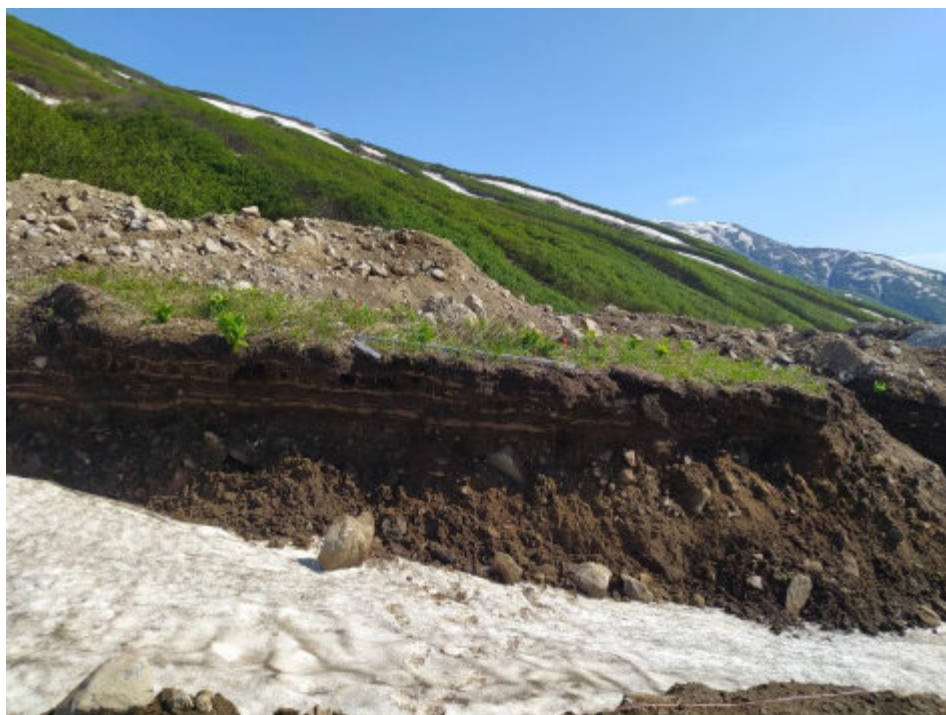
Илл. 49. Объект «Строительство горно-обогатительного комбината на месторождении Кумроч в Усть-Камчатском муниципальном районе Камчатского края. 1 очередь. Подземный рудник с объектами инфраструктуры». Зачистка № 13. Место закладки зачистки. Вид с юго-запада
