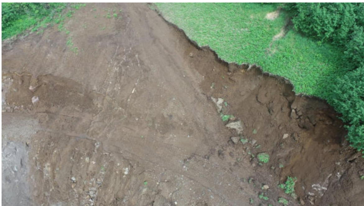
Илл. 163. Объект «Строительство горно-обогатительного комбината на месторождении Кумроч в Усть-Камчатском муниципальном районе Камчатского края. 1 очередь. Подземный рудник с объектами инфраструктуры». Точка фотофиксации № 53. Вид с юго-востока
