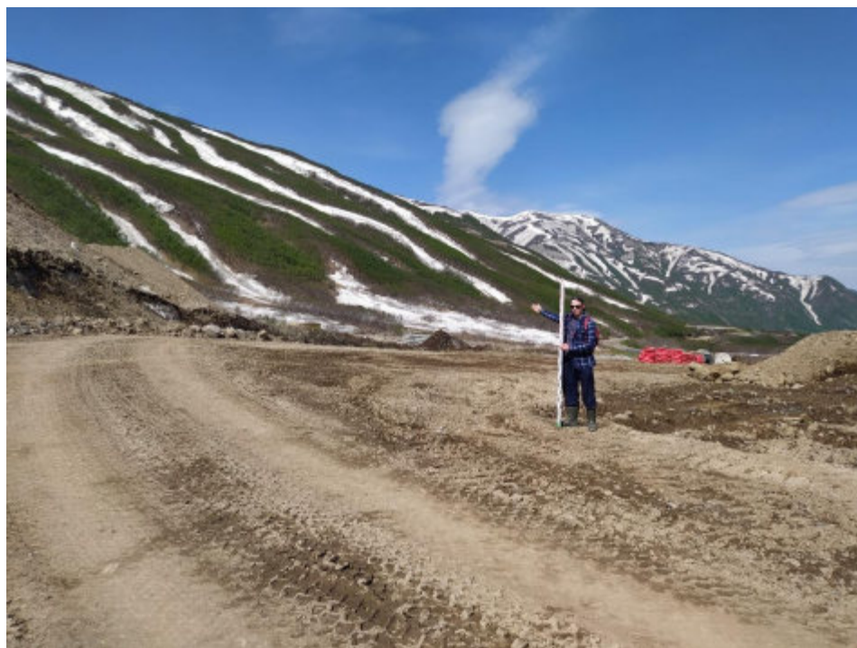
Илл. 9. Общий вид на «Объект «Строительство горно-обогатительного комбината на месторождении Кумроч в Усть-Камчатском муниципальном районе Камчатского края. 1 очередь. Подземный рудник с объектами инфраструктуры». Вид с на северо-восточную часть объекта с юго-запада
