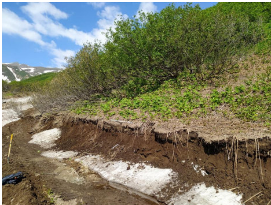
Илл. 53. Объект «Строительство горно-обогатительного комбината на месторождении Кумроч в Усть-Камчатском муниципальном районе Камчатского края. 1 очередь. Подземный рудник с объектами инфраструктуры». Зачистка № 14. Место закладки зачистки. Вид с востока
