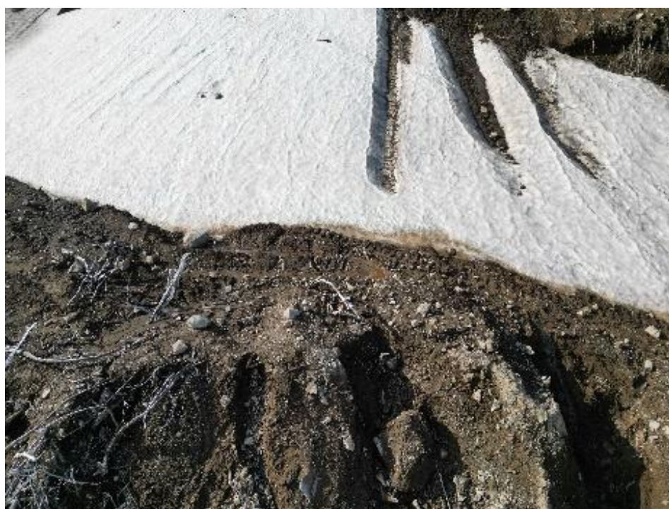
Илл. 146. Объект «Строительство горно-обогатительного комбината на месторождении Кумроч в Усть-Камчатском муниципальном районе Камчатского края. 1 очередь. Подземный рудник с объектами инфраструктуры». Точка фотофиксации № 36. Вид с юга
