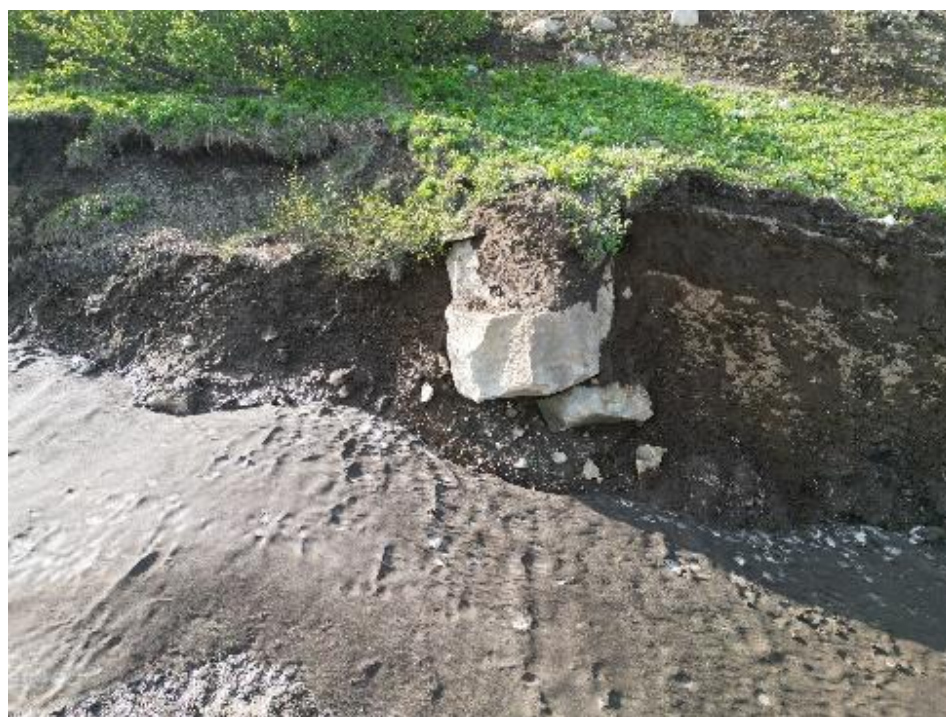
Илл. 150. Объект «Строительство горно-обогатительного комбината на месторождении Кумроч в Усть-Камчатском муниципальном районе Камчатского края. 1 очередь. Подземный рудник с объектами инфраструктуры». Точка фотофиксации № 40. Вид с юго-востока
