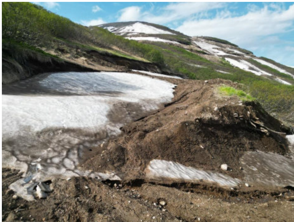
Илл. 123. Объект «Строительство горно-обогатительного комбината на месторождении Кумроч в Усть-Камчатском муниципальном районе Камчатского края. 1 очередь. Подземный рудник с объектами инфраструктуры». Точка фотофиксации № 13. Вид с юга
