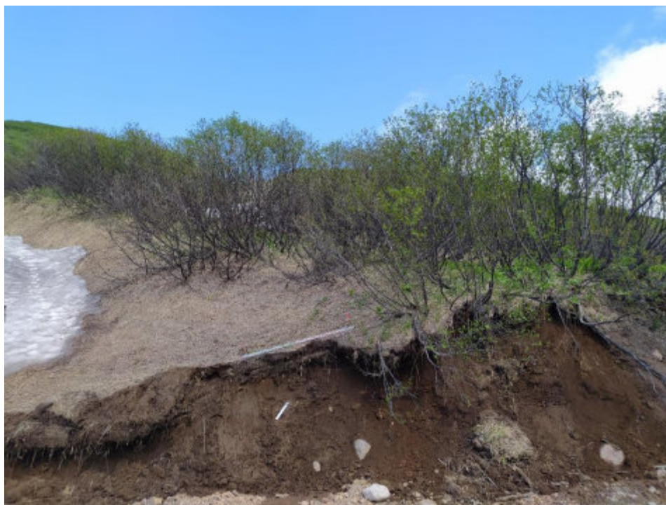
Илл. 67. Объект «Строительство горно-обогатительного комбината на месторождении Кумроч в Усть-Камчатском муниципальном районе Камчатского края. 1 очередь. Подземный рудник с объектами инфраструктуры». Зачистка № 19. Место закладки зачистки и её вид перед раскопкой. Вид с юго-востока
