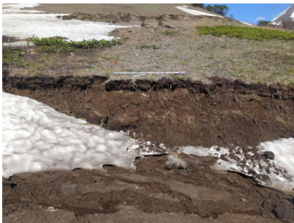
Илл. 96. Объект «Строительство горно-обогатительного комбината на месторождении Кумроч в Усть-Камчатском муниципальном районе Камчатского края. 1 очередь. Подземный рудник с объектами инфраструктуры». Зачистка № 28. Место закладки зачистки. Вид с востока
