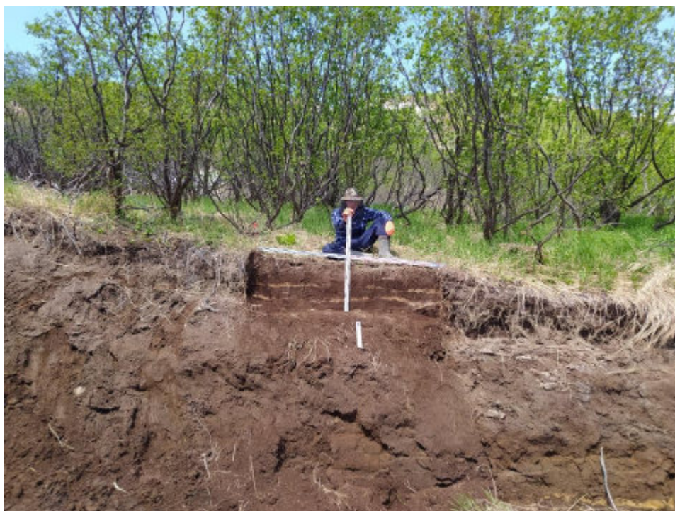
Илл. 79. Объект «Строительство горно-обогатительного комбината на месторождении Кумроч в Усть-Камчатском муниципальном районе Камчатского края. 1 очередь. Подземный рудник с объектами инфраструктуры». Зачистка № 22 после раскопки. Вид с юга
