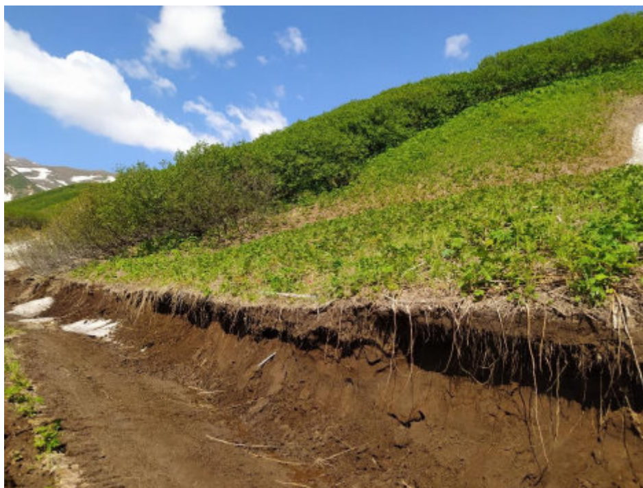
Илл. 57. Объект «Строительство горно-обогатительного комбината на месторождении Кумроч в Усть-Камчатском муниципальном районе Камчатского края. 1 очередь. Подземный рудник с объектами инфраструктуры». Зачистка № 15. Место закладки зачистки. Вид с востока
