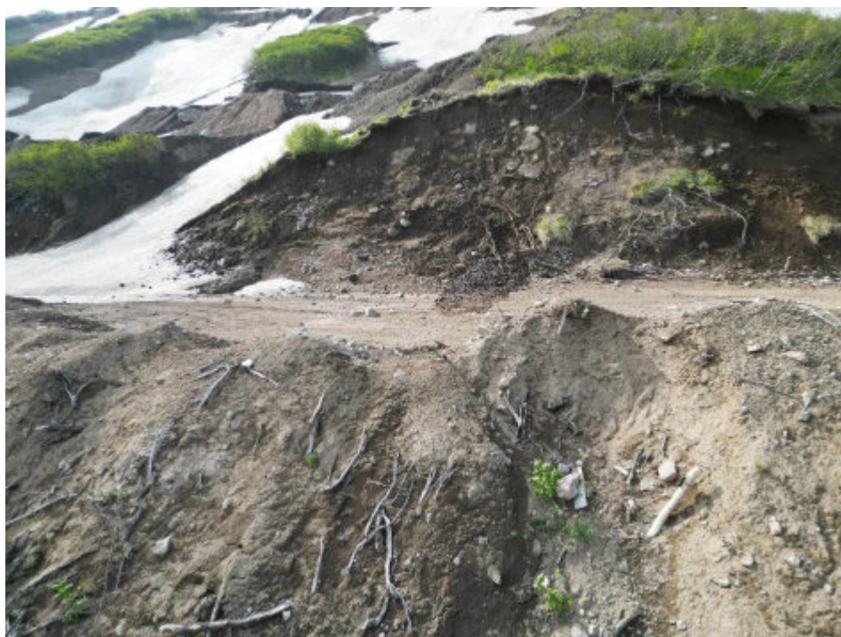
Илл. 126. Объект «Строительство горно-обогатительного комбината на месторождении Кумроч в Усть-Камчатском муниципальном районе Камчатского края. 1 очередь. Подземный рудник с объектами инфраструктуры». Точка фотофиксации № 16. Вид с юго-востока
