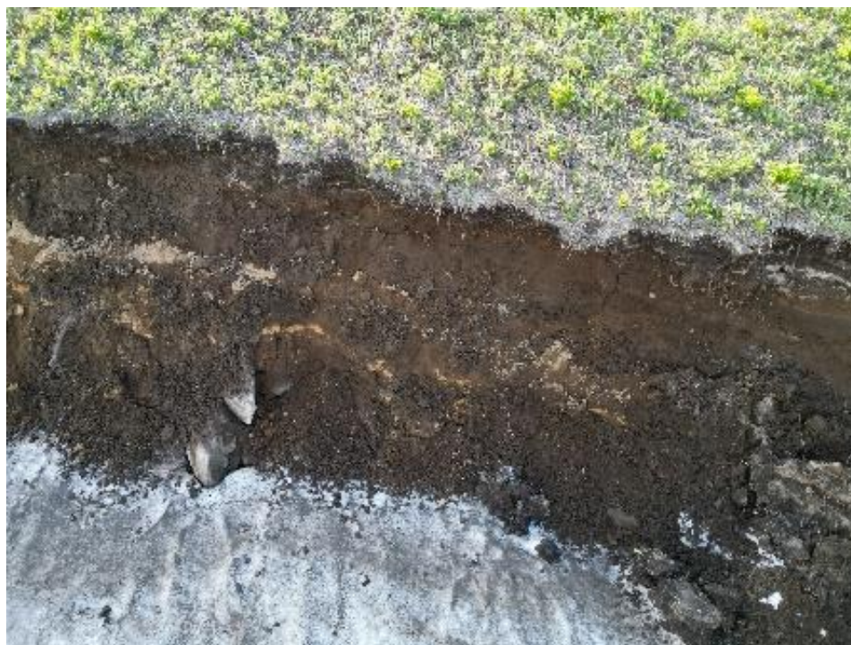
Илл. 149. Объект «Строительство горно-обогатительного комбината на месторождении Кумроч в Усть-Камчатском муниципальном районе Камчатского края. 1 очередь. Подземный рудник с объектами инфраструктуры». Точка фотофиксации № 39. Вид с юго-востока
