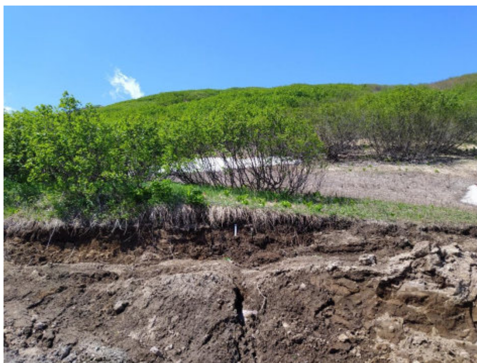
Илл. 84. Объект «Строительство горно-обогатительного комбината на месторождении Кумроч в Усть-Камчатском муниципальном районе Камчатского края. 1 очередь. Подземный рудник с объектами инфраструктуры». Зачистка № 24. Место закладки зачистки. Вид с юга
