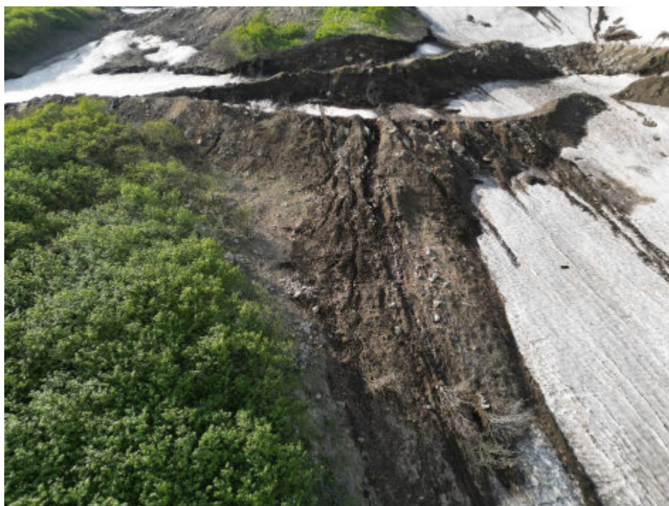
Илл. 130. Объект «Строительство горно-обогатительного комбината на месторождении Кумроч в Усть-Камчатском муниципальном районе Камчатского края. 1 очередь. Подземный рудник с объектами инфраструктуры». Точка фотофиксации № 20. Вид с юго-востока
