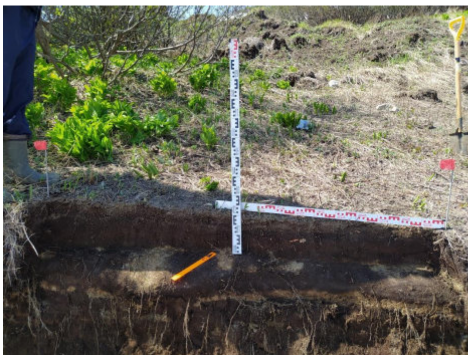
Илл. 46. Объект «Строительство горно-обогатительного комбината на месторождении Кумроч в Усть-Камчатском муниципальном районе Камчатского края. 1 очередь. Подземный рудник с объектами инфраструктуры». Зачистка № 11 после раскопки. Вид с юго-востока
