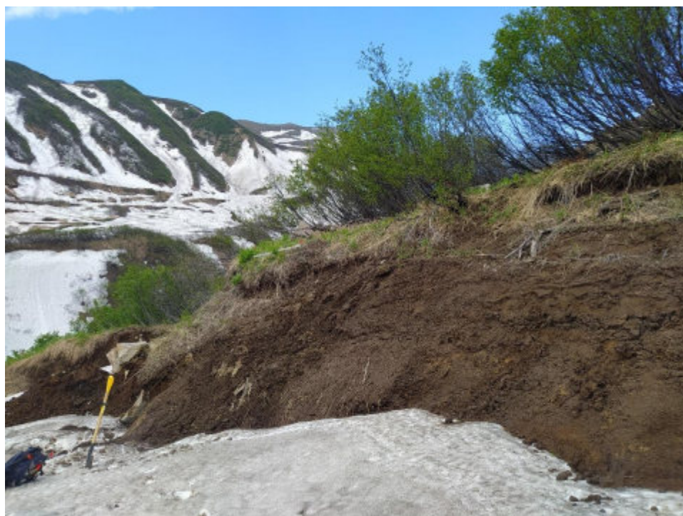
Илл. 16. Объект «Строительство горно-обогатительного комбината на месторождении Кумроч в Усть-Камчатском муниципальном районе Камчатского края. 1 очередь. Подземный рудник с объектами инфраструктуры». Зачистка № 2. Место закладки зачистки. Вид с востока
