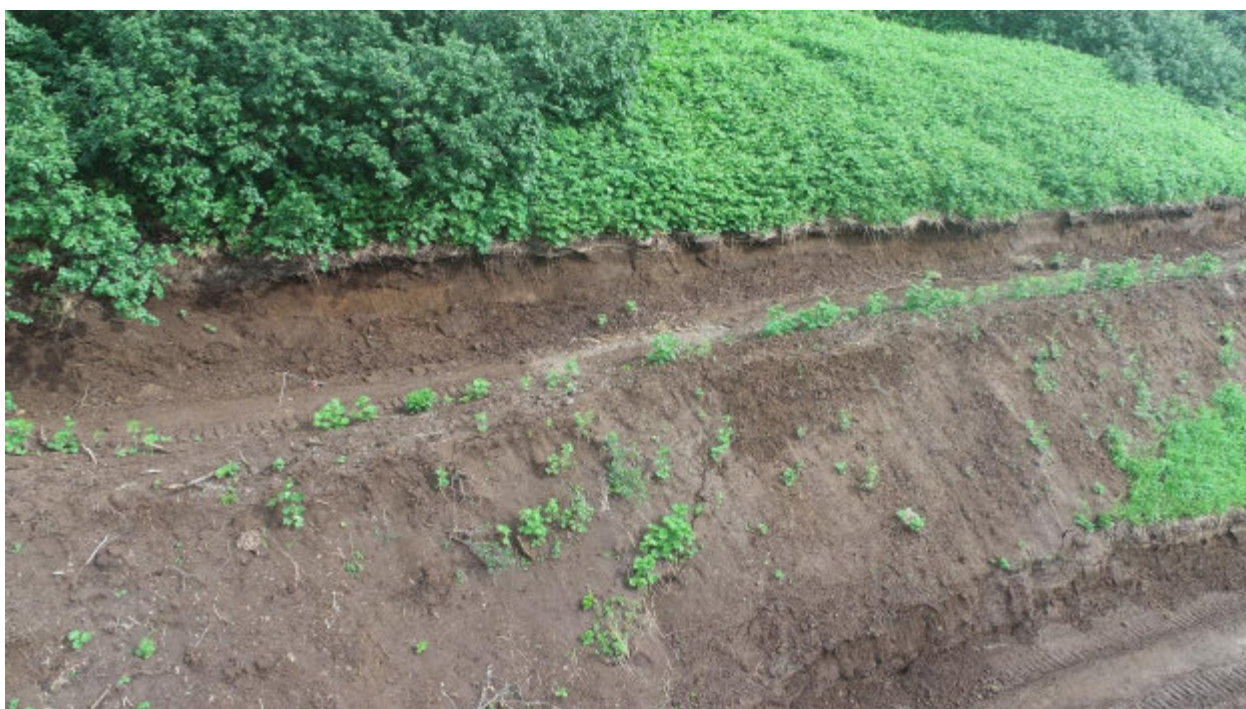
Илл. 162. Объект «Строительство горно-обогатительного комбината на месторождении Кумроч в Усть-Камчатском муниципальном районе Камчатского края. 1 очередь. Подземный рудник с объектами инфраструктуры». Точка фотофиксации № 52. Вид с юго-востока
