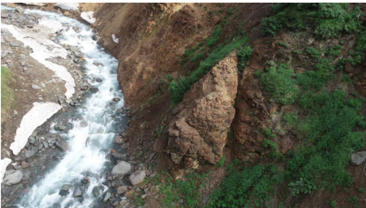
Илл. 158. Объект «Строительство горно-обогатительного комбината на месторождении Кумроч в Усть-Камчатском муниципальном районе Камчатского края. 1 очередь. Подземный рудник с объектами инфраструктуры». Точка фотофиксации № 48. Вид с востока
