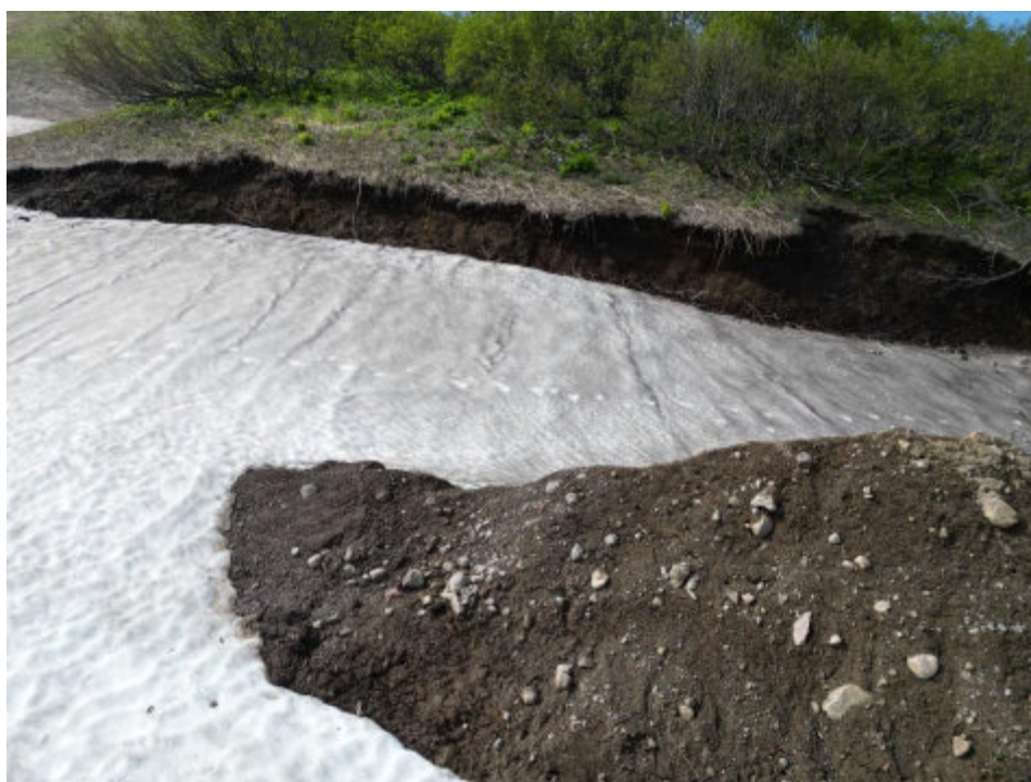
Илл. 114. Объект «Строительство горно-обогатительного комбината на месторождении Кумроч в Усть-Камчатском муниципальном районе Камчатского края. 1 очередь. Подземный рудник с объектами инфраструктуры». Точка фотофиксации № 4. Вид с юга
