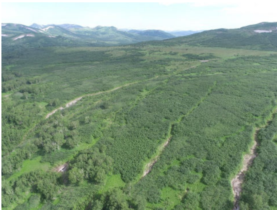
Илл. 167. Объект «Строительство горно-обогатительного комбината на месторождении Кумроч в Усть-Камчатском муниципальном районе Камчатского края. 1 очередь. Подземный рудник с объектами инфраструктуры». Точка фотофиксации № 57. Вид с севера
