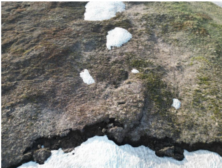
Илл. 139. Объект «Строительство горно-обогатительного комбината на месторождении Кумроч в Усть-Камчатском муниципальном районе Камчатского края. 1 очередь. Подземный рудник с объектами инфраструктуры». Точка фотофиксации № 29. Вид с юго-востока
