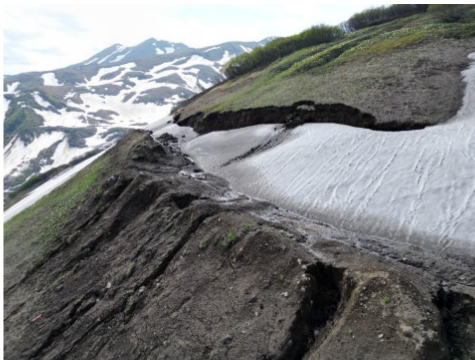
Илл. 115. Объект «Строительство горно-обогатительного комбината на месторождении Кумроч в Усть-Камчатском муниципальном районе Камчатского края. 1 очередь. Подземный рудник с объектами инфраструктуры». Точка фотофиксации № 5. Вид с востока
