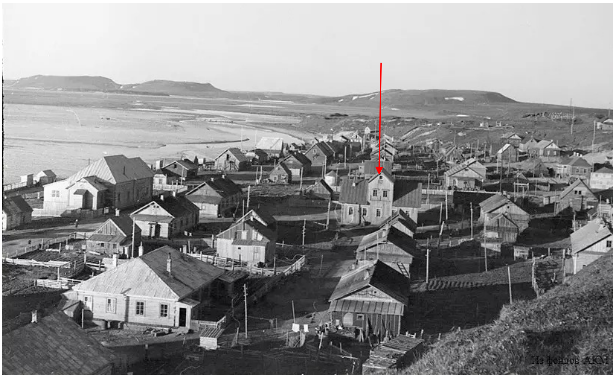
13. Алеутский район. Общий вид на село Никольское. 1956 г. К этому времени утрачен балкон.
