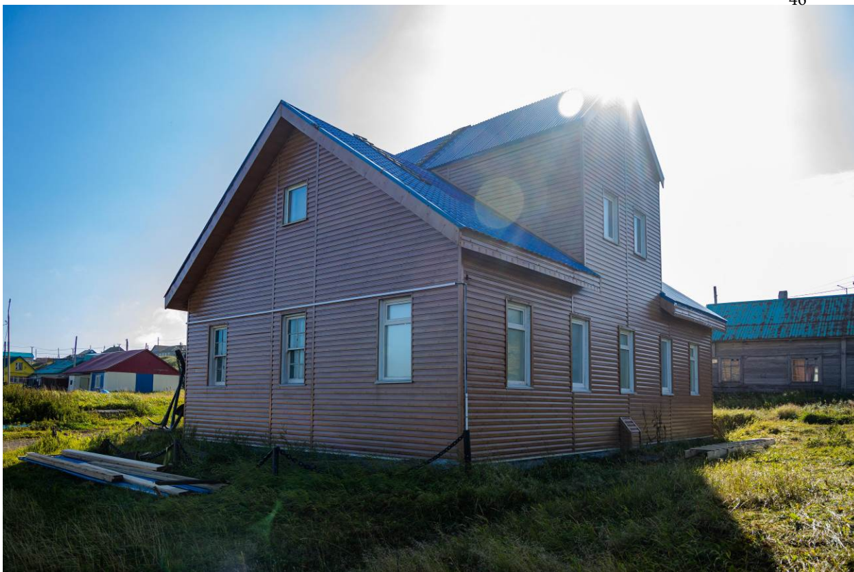
Фото 1. Выявленный объект культурного наследия «Здание «Уездное управление» (в настоящее время в здании располагается МБУ «Алеутский краеведческий музей»). Общий вид с северо-запада. Автор: Дубинин И.В. Дата съемки: 05.08.2022
