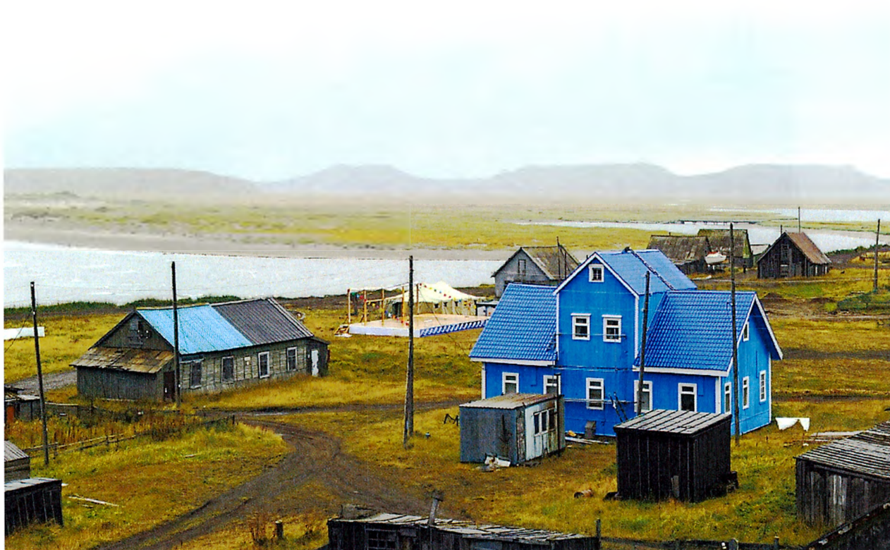
Фото 3. Общий вид объекта. 2010-ые годы
