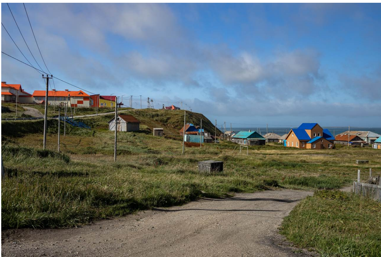
Фото 6. Выявленный объект культурного наследия «Здание «Уездное управление» (в настоящее время в здании располагается МБУ «Алеутский краеведческий музей»). Общий вид с востока. Автор: Дубинин И.В. Дата съемки: 05.08.2022
