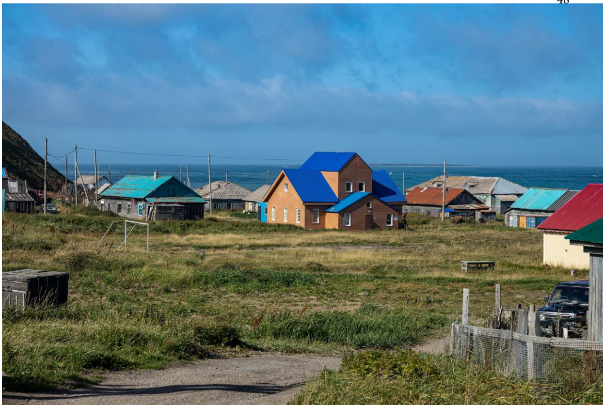
Фото 5. Выявленный объект культурного наследия «Здание «Уездное управление» (в настоящее время в здании располагается МБУ «Алеутский краеведческий музей»). Общий вид с востока. Автор: Дубинин И.В. Дата съемки: 05.08.2022
