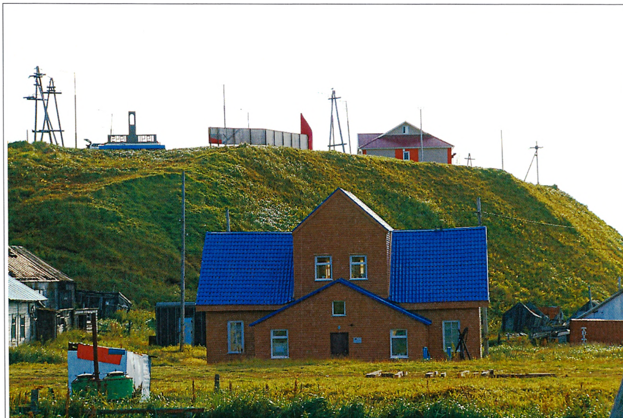
Фото 1. Общий вид объекта. 2020 год
