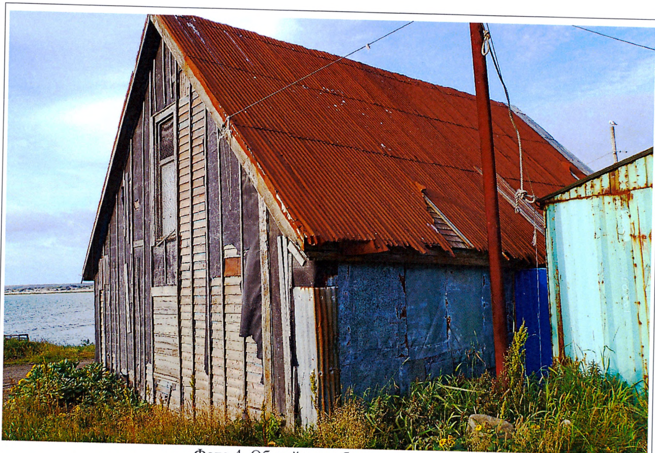
Фото 4. Общий вид объекта. 2020 год
