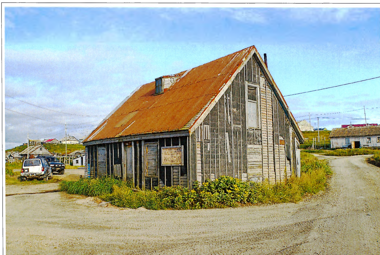
Фото 1. Общий вид объекта. 2020 год
