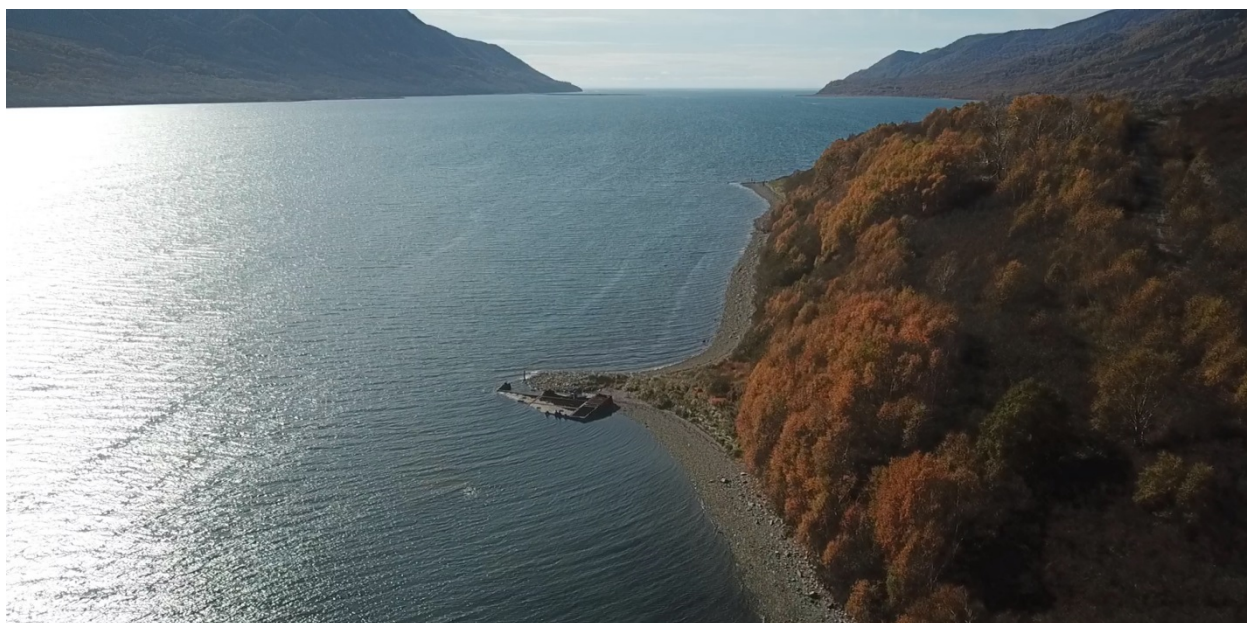
Рисунок 39. Разрушенный причал. Вид с СВ.
