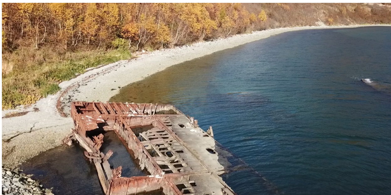
Рисунок 41. Остов плавучего причала рядом с разрушенным причалом.
