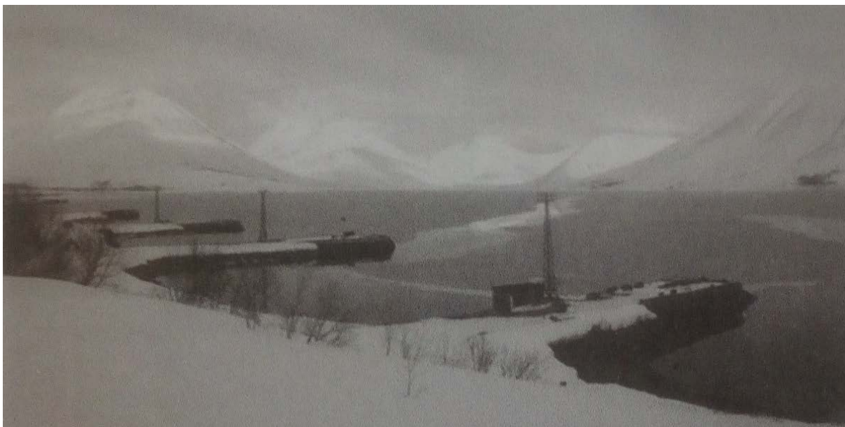
Рисунок 16. Пустые пирсы базы 182-й Отдельной бригады подводных лодок. Бчевинская бухта. 1996 г. (Сенькин В.А, 2015. С.765.)
